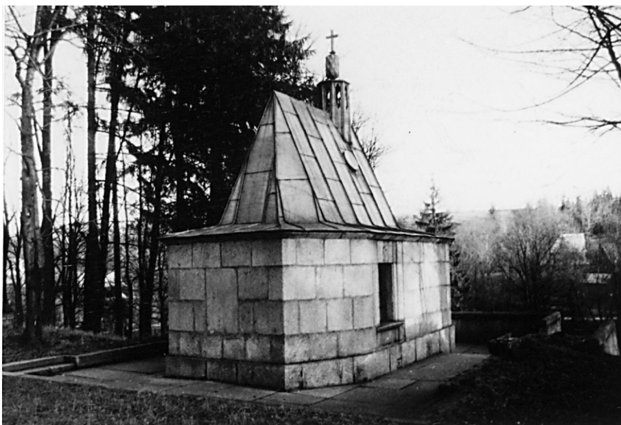
il. 2. Widok na drugą kondygnację mauzoleum Kasprów, od tyłu, 2000 r., D. Możdziej, fotografia ze zbiorów NID, karta ewidencyjna zabytków architektury i budownictwa, nr 12501, p. 6
